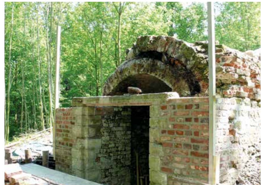
Dubbel gewelf ijskelder Kasteel de Ribaucourt (RLGC vzw)
