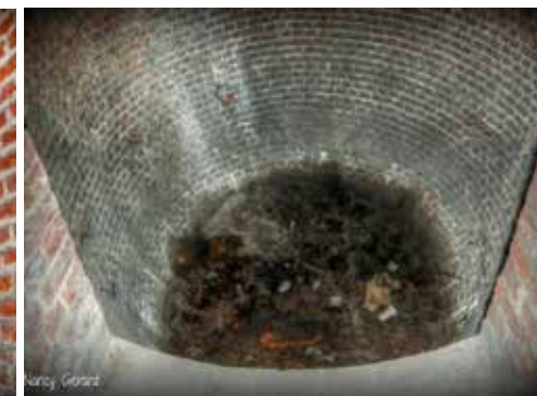
Centraal in de kelders van het 19e eeuwse Sint-Pietersgasthuis (Leuven) werd een aparte ijskelder ingebouwd voor de bewaring van medicinaal ijs (Nancy Gérard)
